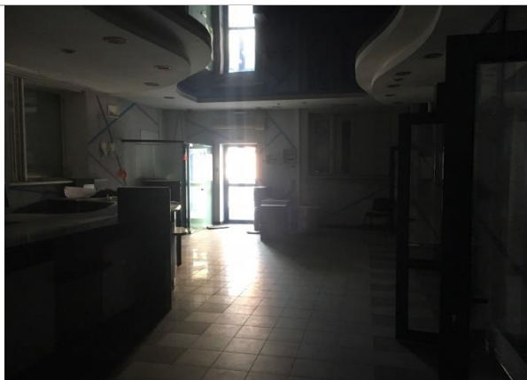
Фото 18. Внутреннее состояние помещений
