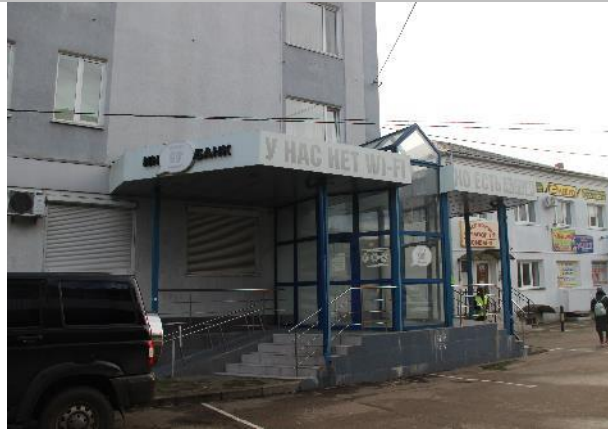
Фото 7. Внешнее состояние объекта.
