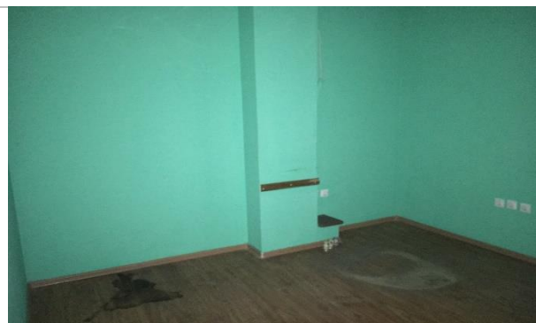
Фотография 3.7. Внутреннее состояние помещений
