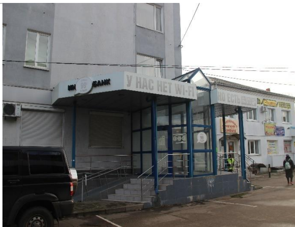
Фотография 3.2. Внешнее состояние объекта
