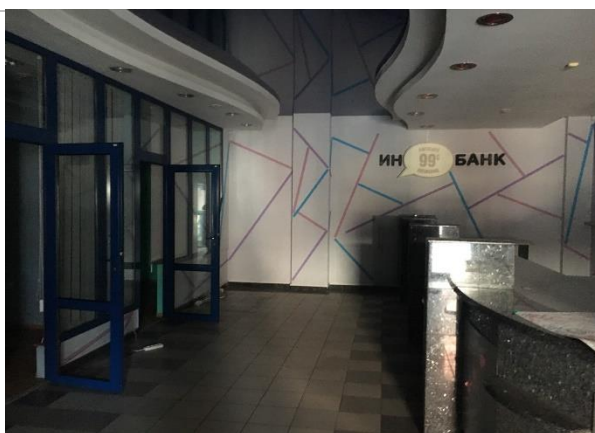
Фото 16. Внутреннее состояние помещений
