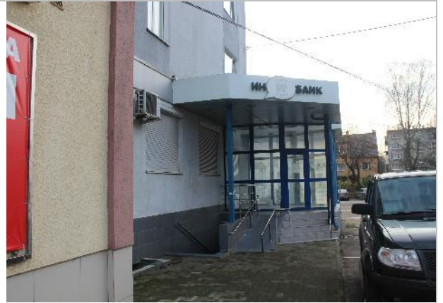
Фото 8. Внешнее состояние объекта.
