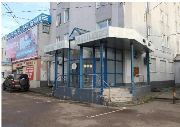
Фото 4. Внешнее состояние объекта.
