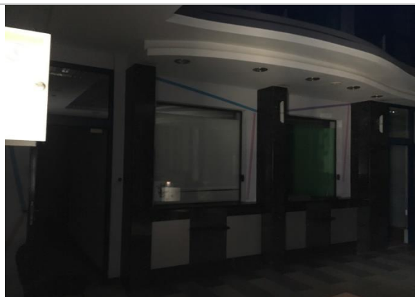
Фото 13. Внутреннее состояние помещений
