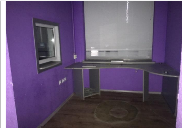
Фото 19. Внутреннее состояние помещений
