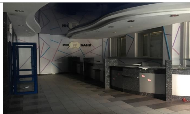
Фотография 3.5. Внутреннее состояние помещений
