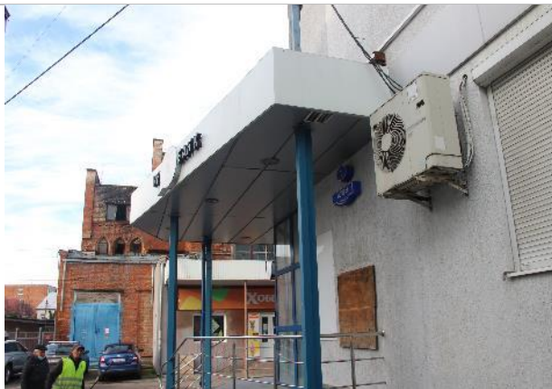
Фото 6. Внешнее состояние объекта.
