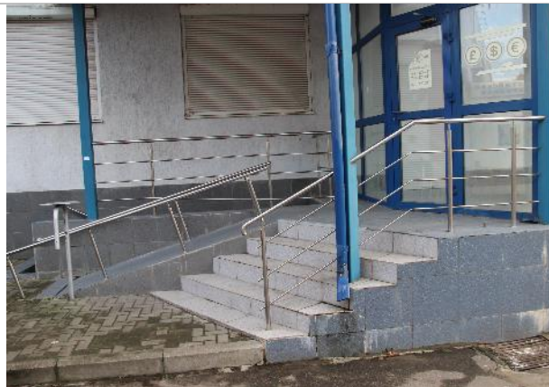
Фото 11. Внешнее состояние объекта.
