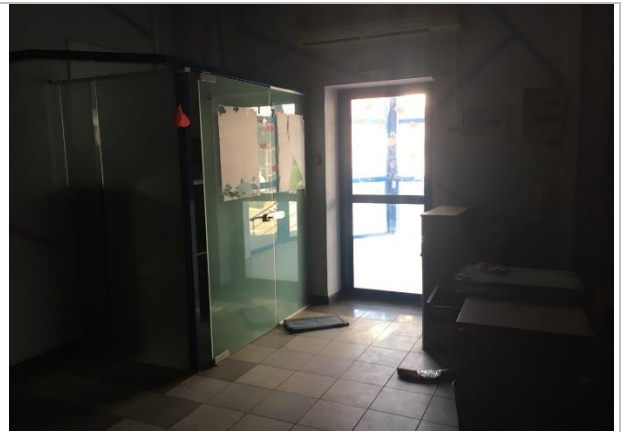
Фото 20. Внутреннее состояние помещений
