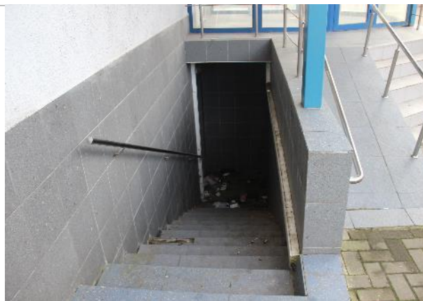
Фото 9. Внешнее состояние объекта.
