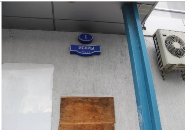
Фото 5. Внешнее состояние объекта.
