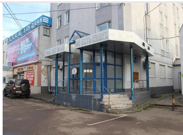
Фотография 3.1. Внешнее состояние объекта
