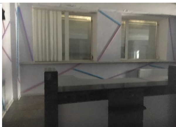
Фото 15. Внутреннее состояние помещений
